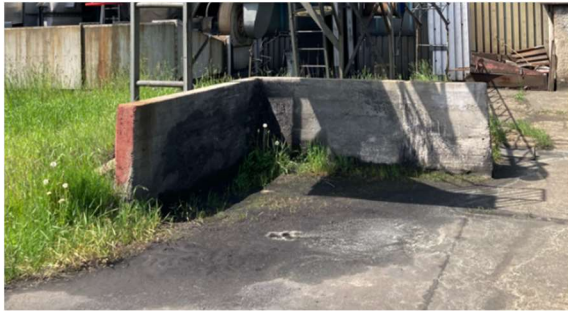
Fot. 3 demontaż istniejącej ściany betonowej
